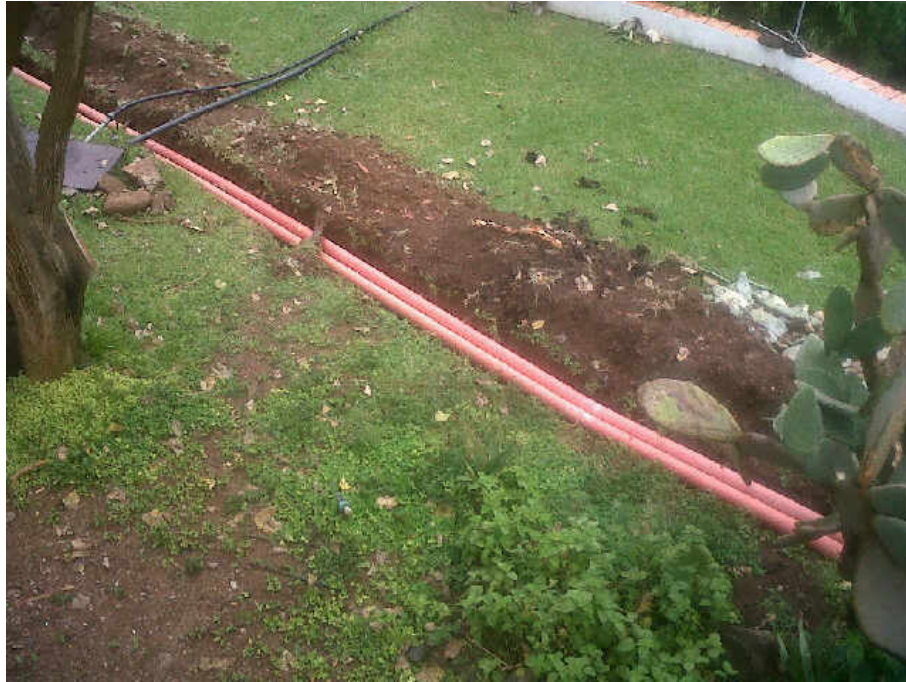
Figura 3 Trincheras y tuberías de 4", jardín adyacente a la Casa Colonial
