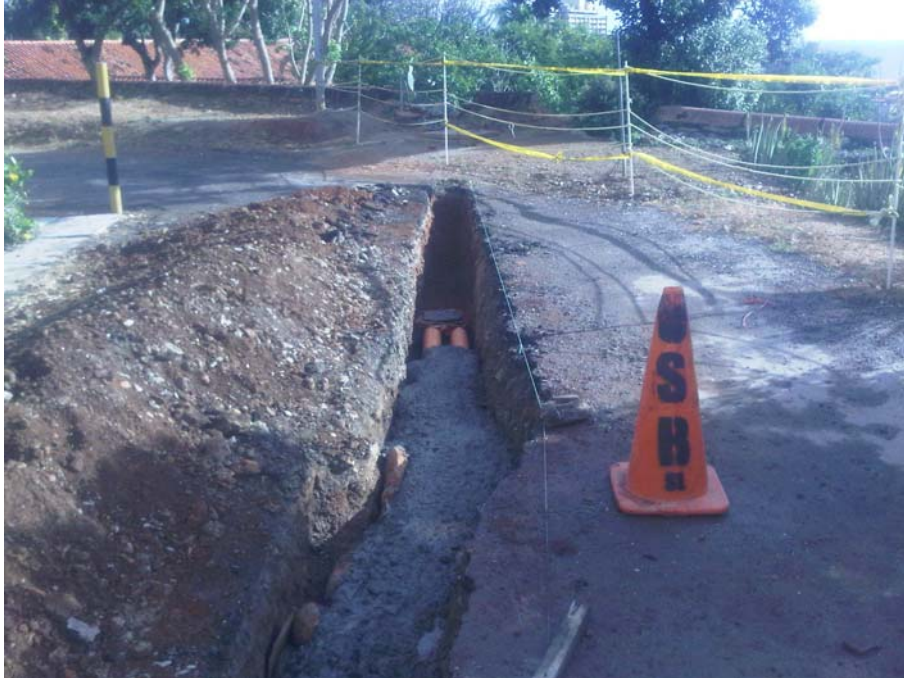
Figura 5 Trinchera y tuberías de 4", área de acceso entre el Cafetín y la Casa Colonial
