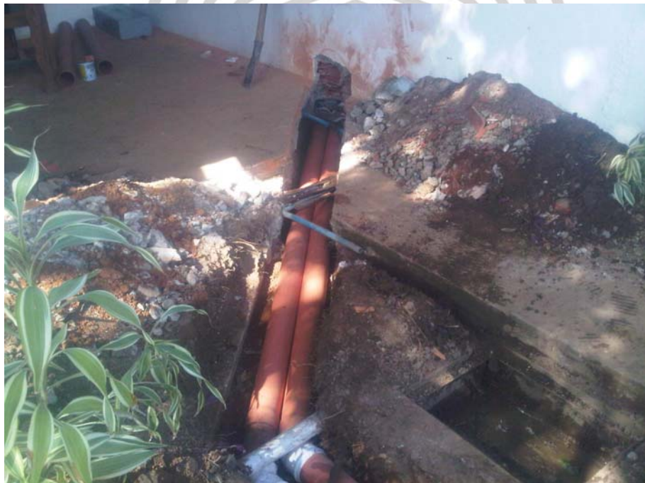
Figura 2 Trinchera y tuberías de 4", área adyacente a la Casa Colonial
